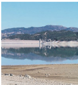
LIVELLI La diga senise di Montecotugno torna a riempirsi
